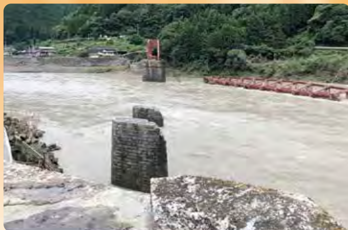
九州豪雨で流失したJR肥薩線『球磨川第一橋梁』
